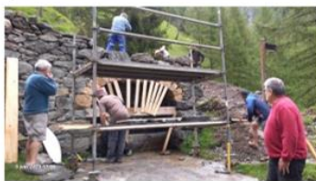
Réfection complète de la voute
